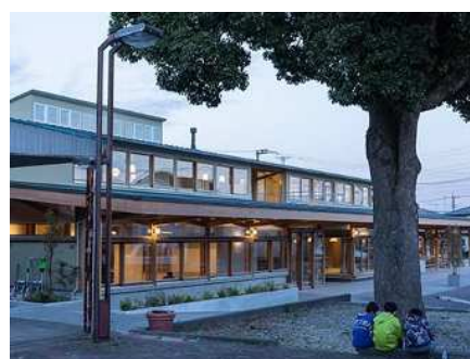
春日台センターセンター(神奈川県愛川町)
